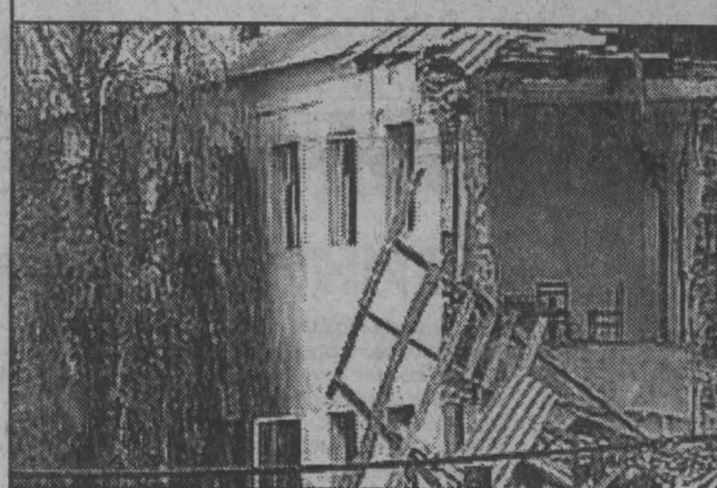
НА СНИМКЕ: разрушенное взрывом здание УБОП в Гудермесе.
