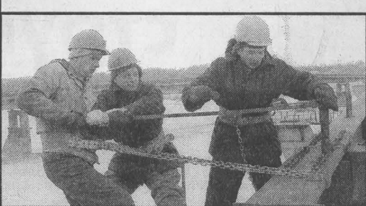
Затяжку болтов на металлоконструкциях моста ведут монтажники Анатолий Гредюшко, бригадир Сергей Подголов и Григорий Султанамедов.
