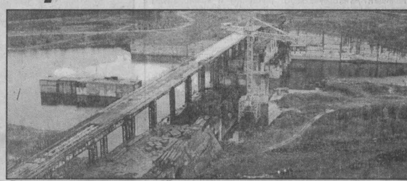
Так выглядела недостроенная плотина Крапивинского водохранилища летом прошлого года.
