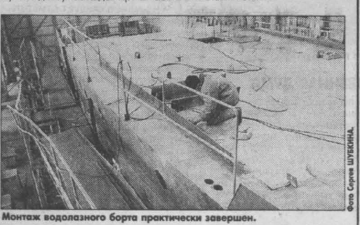
Монтаж водолазного борта практически завершен.
