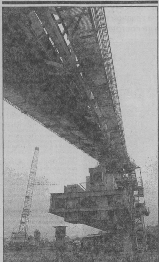
ОАО «Разрез «Бачатский» холдинговой компании «Кузбассразрезуголь» сооружает пятикилометровую конвейерную линию, с вводом которой в эксплуатацию отпадет необходимость вывозить скальный грунт (породу) на автополюк к отвалам. Экономия очевидна. Магистральная конвейер — это, пожалуй, первое крупное сооружение на разрезе. Фото Анатолия Кузьярина.
