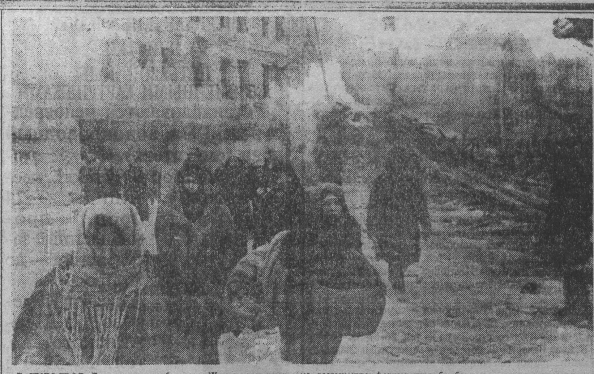
Б. КУДОЯРОВ. Ленинград в дни блокады. Жители покидают дома, разрушенные фашистскими бомбами.
