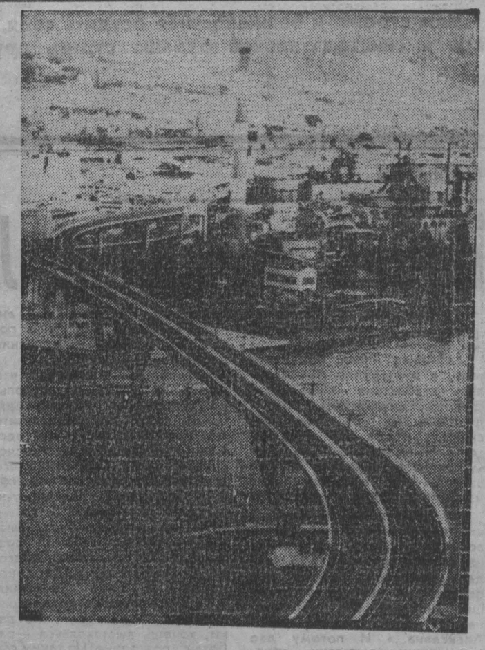
Закончено строительство в-образного моста (на снимке) в западной части японского города Кобе. Мост длиной 400 метров является частью 10,5-километрового путепровода «Харбор лаунд» и соединяет два искусственных острова за пределами Кобе. Теперь он, стоимостью 94 миллиарда иен, строившийся с 1987 года, снимает время пребывания в пути между двумя островами с 30 до 10 минут.
