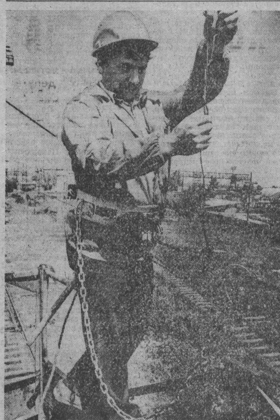
Высокий профессионализм и отличное качество работ видны у рабочих бригады контактной сети Беловского энергостроительства.
