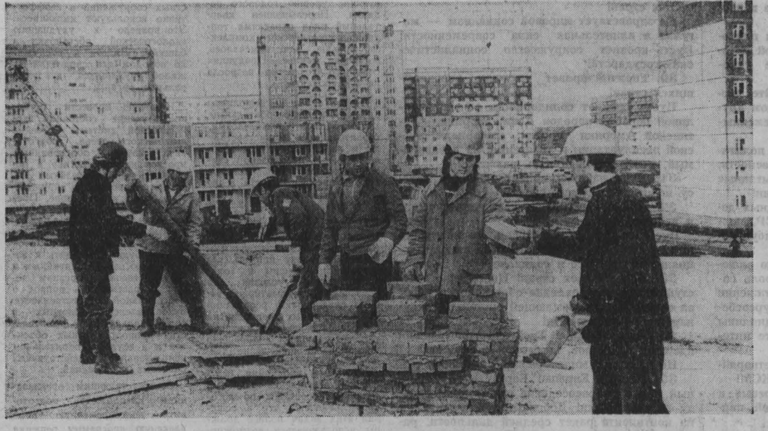
СОТНИ строителей треста «Кемеровогражданстрой» вышли вчера на праздник труда. Хорошо поработала на субботнике бригада Геннадия Алексеевича Понасенко из строительного управления № 6. Этот коллектив строит детский комбинат в двенадцати кварталах. НА СНИМКЕ: бригада Г. А. Понасенко на субботнике. Фото Ю. Сергеева.
