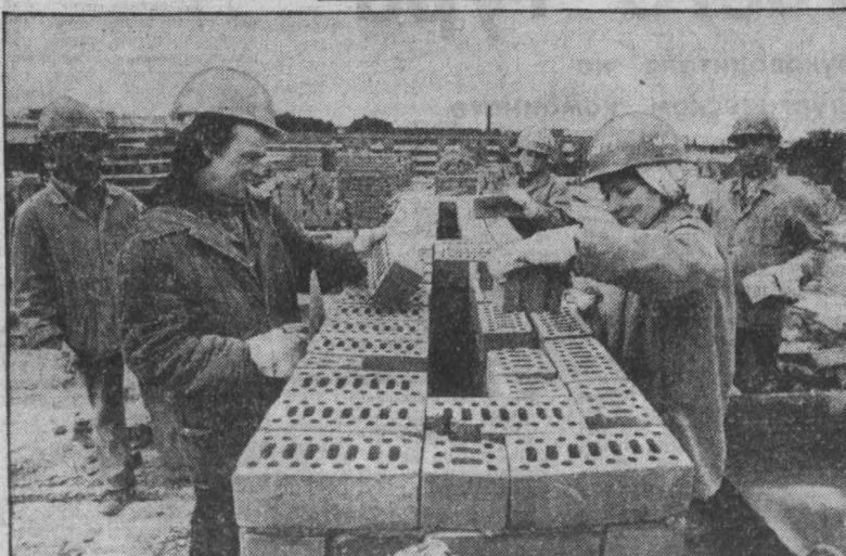
В СТРОИТЕЛЬНО-МОНТАЖНОМ ПОЕЗДЕ № 660 достройтраста бригада каменщиков М. Кузнецова считается одной из лучших. Сегодня коллектив бригады успешно работает на сооружении нового дома для железнодорожников НА СНИМКЕ: бригада Н. Кузнецова на строительстве нового дома. Фото В. Кафо.
