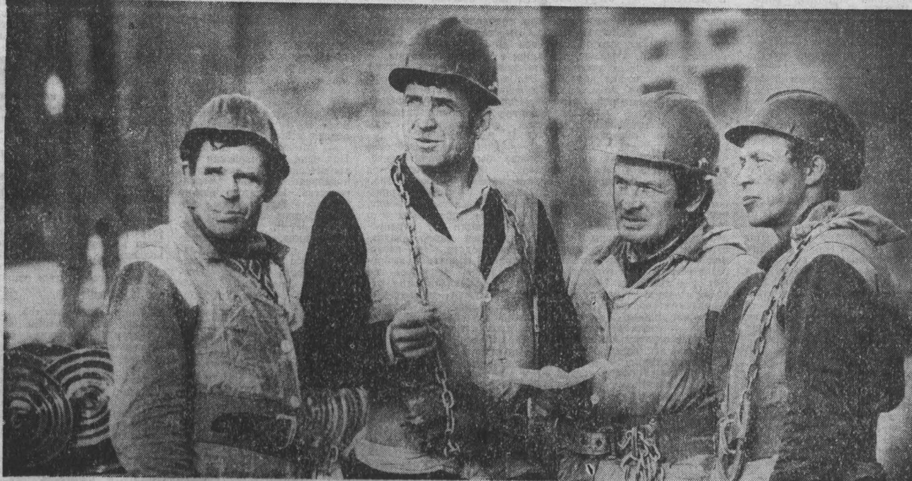
БРИГАДУ электромонтеров контактной сети Николая Кузьмина Рожкова заставил в Калтанском участке энергоснабжения, практически невозможно. Рабочее место коллектива — от станции Кузнецкое до Абагурского разреза. Именно этот участок магистраль закрепили за бригадой. С планом предупредительных работ электромонтеры справляются, вовремя устраняя все неисправности. Вот и сейчас вместе с бригадиром (на снимке в центре) электромонтеры В. Е. Кушнер, А. А. Кошелев и В. В. Марченко готовятся к выполнению очередного задания. Фото Ю. Чулкова.
