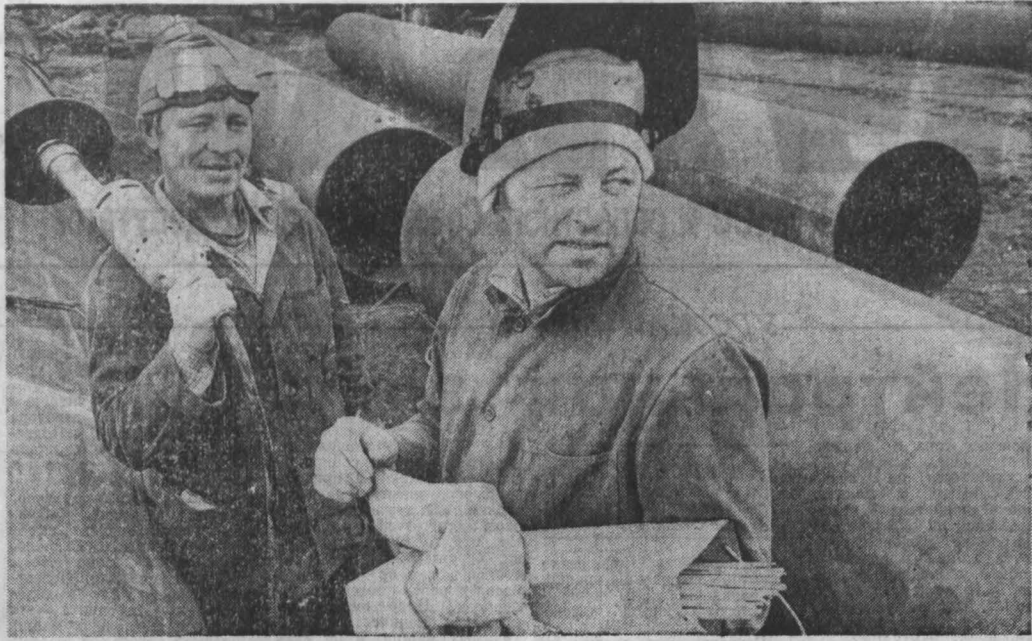
Бригада В. Е. Саломинина с Новокузнецкого участка управления «Кузбассспецпроектстрой» ведет строительство газопровода в поселке Металлосадка. Енисейское это предприятие выполняет норму выработки на 120-130 процентов. Успешно трудится здесь электросварщик В. Р. Деваляд и монтажники В. И. Штанов, г. Кемерово. Фото А. Блотинского.
