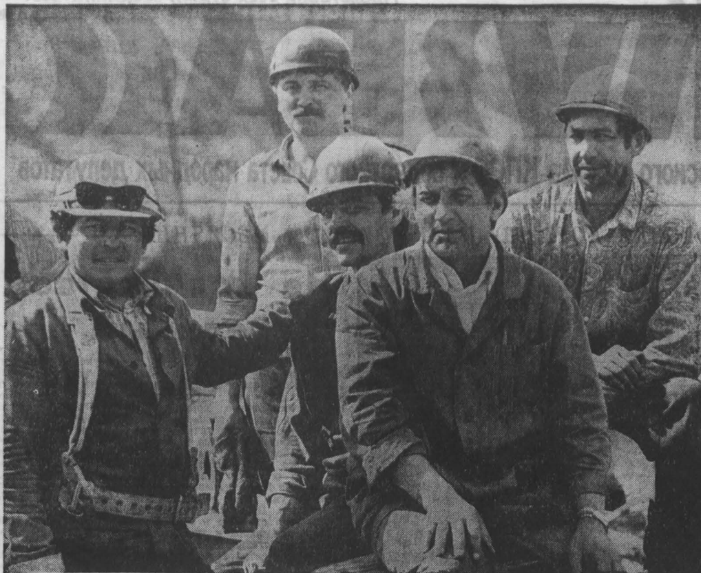
УСПЕШНО трудятся на строительстве Крайинского гидроэлектростанции бригады И. И. Денисова из монтажного управления «Спецгидроэнерго». Выполняемые этим коллективом
