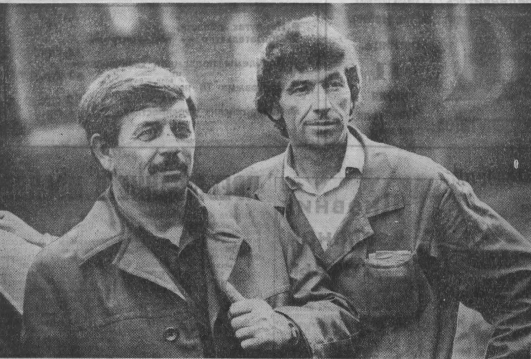
Бригады плотничьих бригад М. П. Берно и А. Н. Калашников трудятся в Томском строительном управлении на возведении жилых корпусов в шахтерском городе. Эти коллективы постоянно соревнуются между собой, и часто входят победителями среди районных бригад управления. На днях строители поздравили своих лидеров с высоким производственным наградами. НАСНИМКЕ, кавалеры ордена Трудовой Славы III степени М. П. Берно и А. Н. Калашников. Фото Ю. Мальцева.
