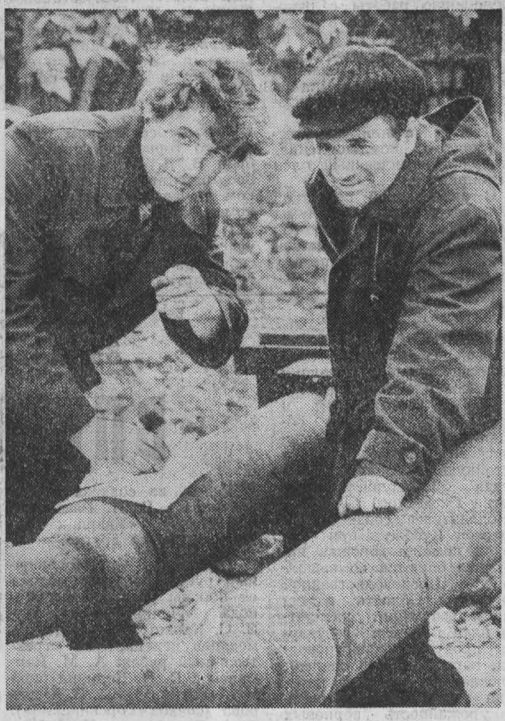
41,5 тысяч рублей — таков экономический эффект, внесенный рационализаторами в Кемеровском монтажном управлении № 3 треста «Сибметаллургмонтаж». Новшества, внедренные в производство, позволили ликвидировать ряд процессов ручного труда, повысить качество сварочных и монтажных работ.
