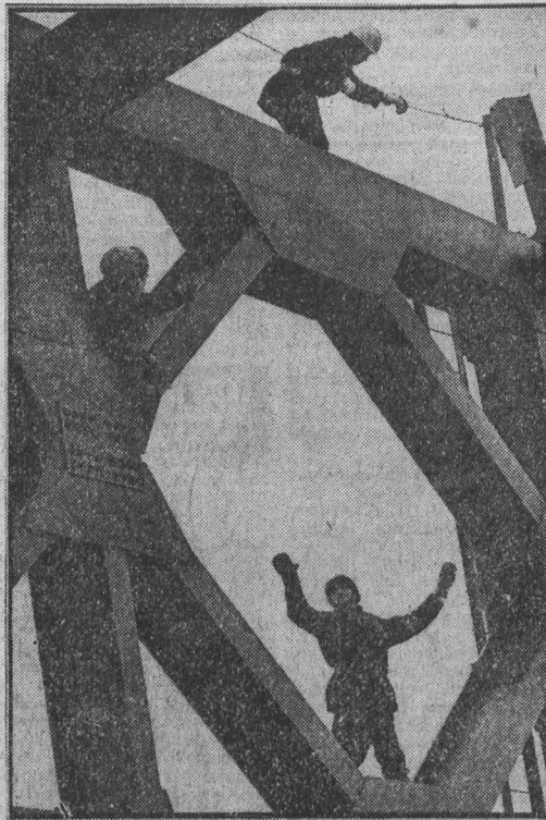
НА СТРОИТЕЛЬСТВЕ Дворца спорта в эти дни идет монтаж переходных мостиков для обслуживания осветительного оборудования. Ответственное задание выполняет монтажная бригада А. П. Чернова из Кемеровского специализированного монтажного управления треста «Сибстальконструкция».
