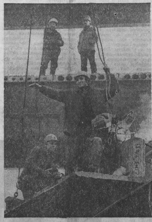
Хорошо поработала в этот день на спорткомплексе бригада монтажников А. П. Чернова из треста «Сибстальконструкция».
