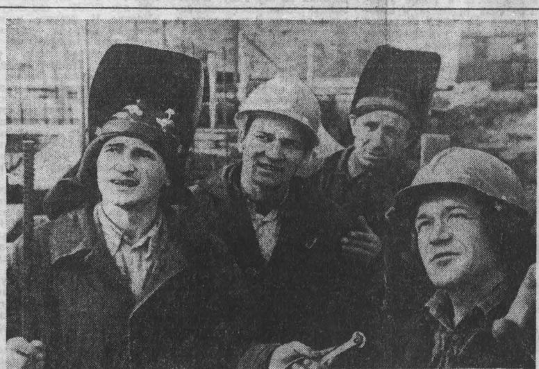
В ГОРОДЕ БЕЛОВО Идет строительство завода по ремонту механизированной крепи. Его первую очередь намерены ввести в строй в конце 1983 года. Один из важных объектов на строительстве котельная. Сегодня здесь трудятся несколько бригад. Среди них и коллектив заслуженного строителя РСФСР И. Л. Гриднева из Талдинского ПМК. Его бригада ведет армирование бунера и строительство водогрейной части котельной.
