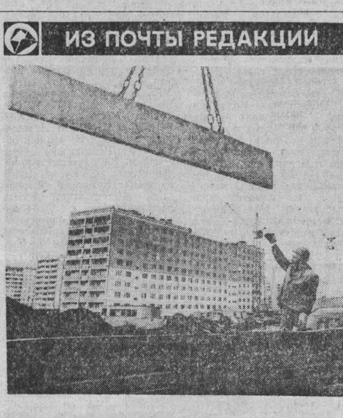
Полным ходом идут монтажные работы на строительстве 18-го квартала нового района Шалготарья.
