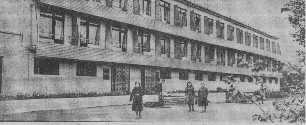
Рядом с центральной проходной завода «Кузбассцемент» расположено новое трехэтажное здание заводского профкома. Лечебные кабинеты оснащены новейшим оборудованием.
