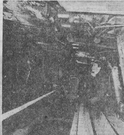
НА СНИМКЕ: лава № 717, в которой трудится бригада И. З. Сафронова, оснащена комплексом МК-755. Среднесуточная нагрузка превышает полторы тысячи тонн. Беспечной очисткой комбайн — новинку горной техники ведет машинист Вячеслав Денисович Галайда. Фото Н. Шилова. г. Березовский.
