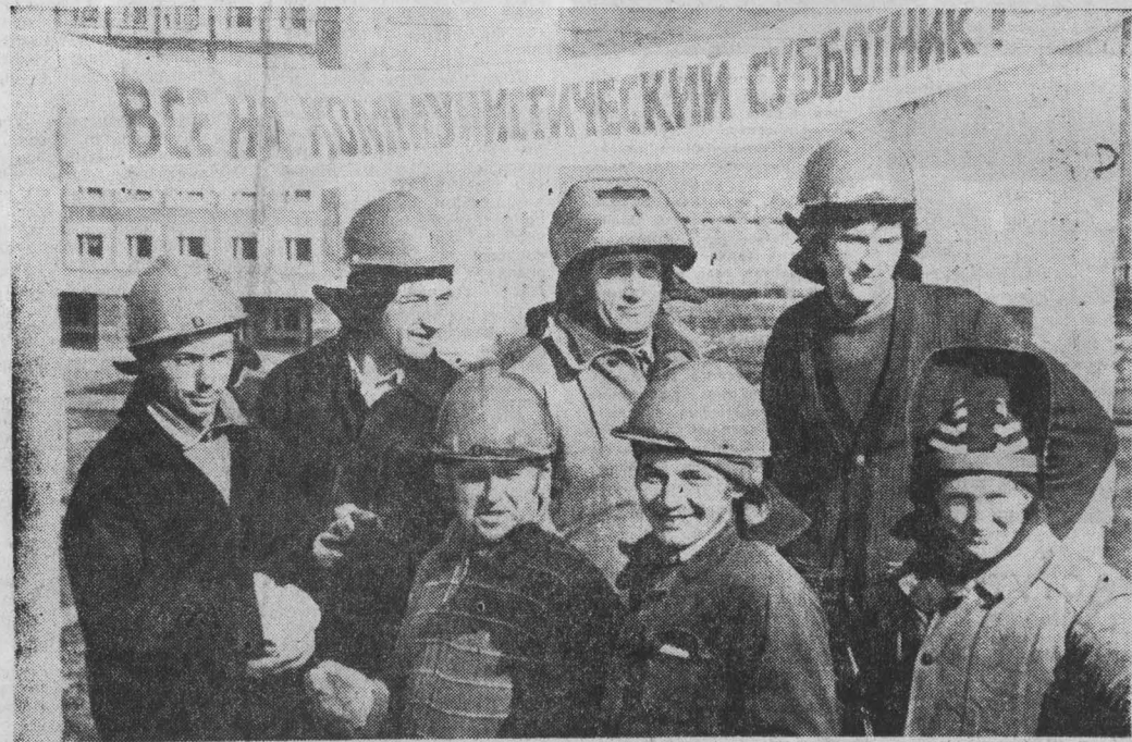
Вместе с тысячами кемеровчан трудились вчера на субботнике строители из бригады коммунистического труда, возглавляет которую А. Ф. Бровка. Этот коллектив считается одним из лучших в третьем управлении треста «Кемероградстрой». Сегодня бригада работает на строительстве нового здания института «Кузбассгипросталь». В день субботника коллектив бригады закончил монтаж четвертого этажа, выполнив дневное задание на 140 процентов.
