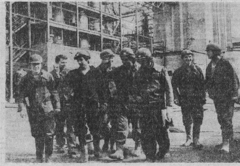
СТУДЕНЧЕСКИЙ строительный отряд Кемеровского государственного института культуры «Мечта» нынешний трудовой семестр провел на стройках областного центра. Сособой теплотой говорят о бойцах ССО «Мечта» в тресте «Строймеханизация». Студенты отлично поработали на благоустройстве территории
