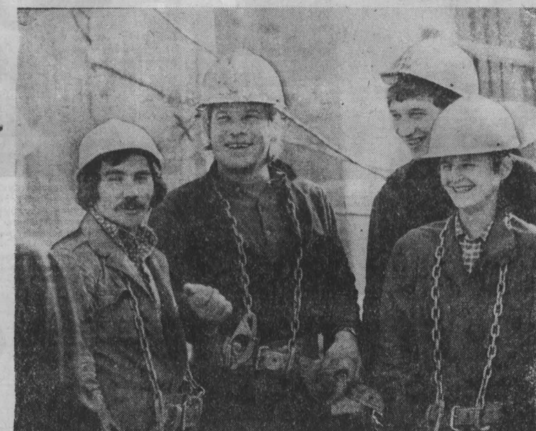
Электромонтажники бригады В. М. Фомченко из КМУ-1 «Запсибэлектромонтаж» с опережением графика ведут монтаж электрооборудования на установке перевода действующего производства амина на метанол на природный газ в мемеросном объединении «Азот».
