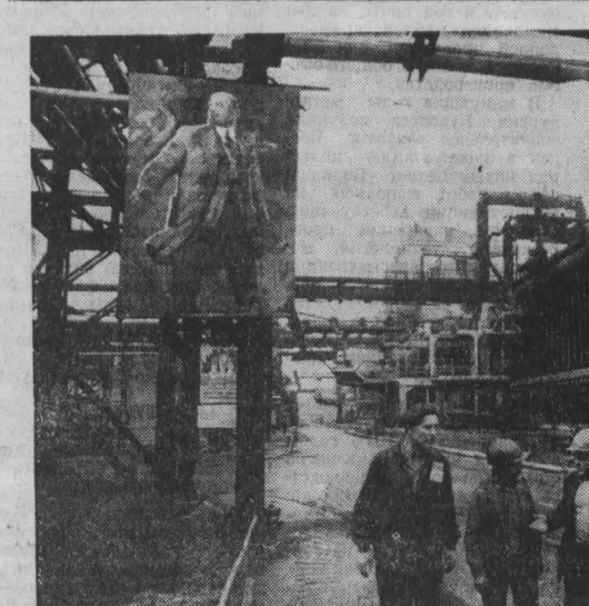
На снимках: машинист вагона А. В. Котков и старший газослужащий В. Г. Свиридов на пятаковской батарее.
