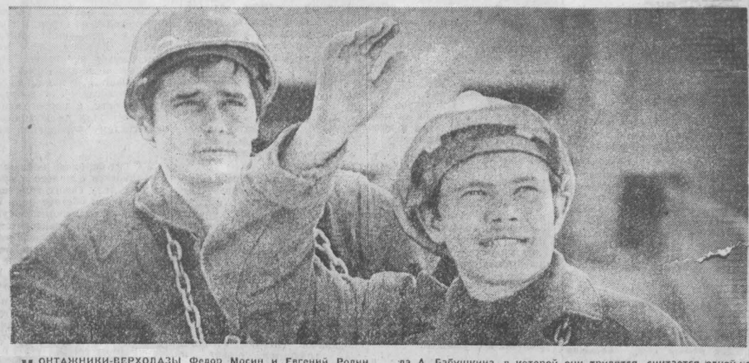
МОНТАЖНИКИ-ВЕРХОЛАЗЫ Федор Мосин и Евгений Родин работают в первом Новокузнецком монтажном управлении треста «Сибметаллургстрой». Опытные специалисты, они успешно выполняют самые сложные монтажные работы. Бригада А. Бабушина, в которой они трудятся, считается одной из ведущих в управлении.
