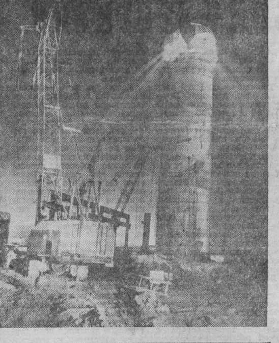
Фрагмент строительства цеха
