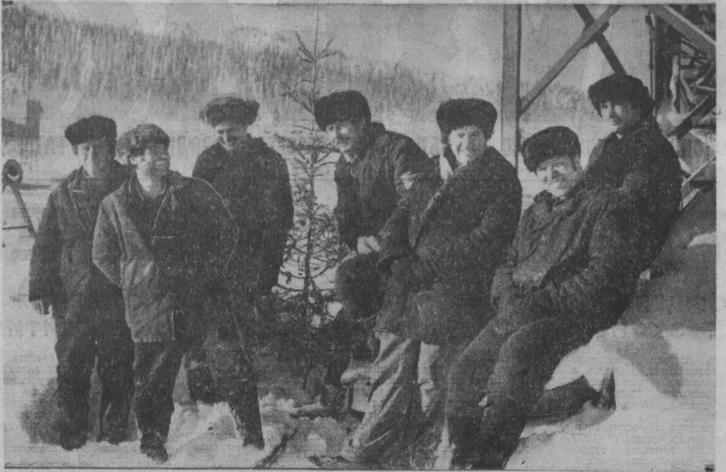
На этом снимке нет только одного члена бригады А. И. Рудневича. Он был в отпуске. А с остальными можно познакомиться: монтажники П. А. Железобойский, П. В. Кузнецов, Г. Я. Бердников, В. М. Бахаев, Н. В. Генсицкий, В. Я. Парыгин и прораб Н. С. Брагин. Многие из них работают вместе по 15—20 лет. Главная задача бригады с Новокузнецкого участка механизация — монтаж крана. Без этой бригады дело не обходится ни на КИМ, ни на Залесие, и на многих других предприятиях нашей области. Самым примечательным событием в жизни бригады был монтаж крана БК-1425, способного поднять груз весом 75 тонн на высоту 120 метров. С помощью этого крана монтировалась военная печь № 1 Залесия. Сейчас бригада работает на строительной площадке новой шахты в поселке Шереметь и ведет монтаж знаменитого, единственного в Кузбассе, крана БК-1425. По плану работы должны быть закончены к 20 февраля, но коллектив принял решение — завершить их к 3 февраля. НА СНИМКЕ: П. А. Железобойский, П. В. Кузнецов, Г. Я. Бердников, В. М. Бахаев, Н. В. Генсицкий, В. Я. Парыгин, Н. С. Брагин. Фото Г. Нефедова.
