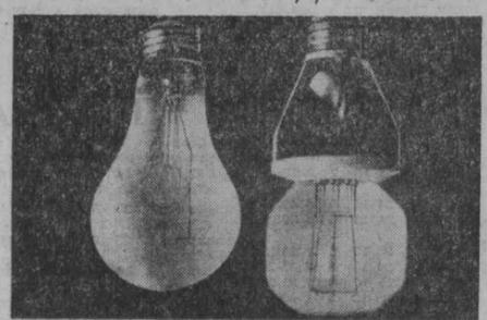
▲ Новый осветительный прибор, который в будущем, возможно, заменит обычную лампу накаливания, изобрели американские специалисты. В нижней части новой лампы (на снимке слева) находится сложное электронное устройство, контролирующее режим работы прибора. Давая свет той же силы, новая лампа потребляет в три раза меньше энергии.
