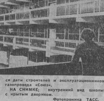
НА СНИМКЕ: внутренний вид школы с крытым двориком. Фотохроника ТАСС.
