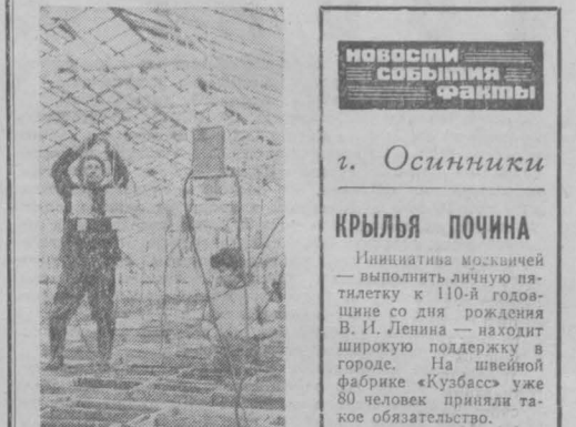
НА СНИМКЕ: ремонтные работы в теплице. Фото А. Шувалова. Новокузнецкий район.
