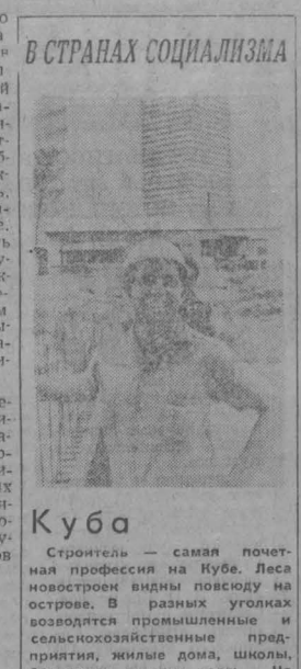
В СТРАНАХ СОЦИАЛИЗМА Куба Строитель — самая почетная профессия на Кубе. Леса новостроек видны повсюду на острове. В разных уголках возводятся промышленные и сельскохозяйственные предприятия, жилые дома, школы, больницы, детские сады. На строительных площадках трудятся почти 300 тысяч рабочих-профессионалов и добровольцев. Большое внимание уделяется жилищному строительству. Тысячи семей трудятся уже переселились в благоустроенные квартиры. За годы пятилетия (1976—1980) планируется сдать в эксплуатацию более 200 тысяч новых квартир. НА СНИМКЕ: строитель из Гаавани Габриэле Монтеро. Фотохроника ТАСС.
