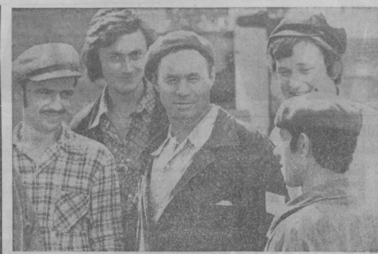
Мем бригадира строителей Б. И. Крутько — лауреата премии Кузбасса — хорошо известно в Новокузнецке. В эти дни прославилась бригадой в СУЗ «Кузнецкпромстрой» трудится трестом на нескольких объектах — ведет монтаж техникума советской торговли, крытого гаража для АТП-2.
