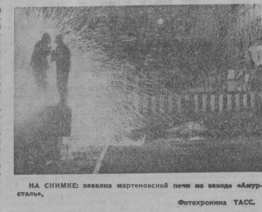
НА СНИМКЕ: завалка мартеновской печи на заводе «Амурсталь».
