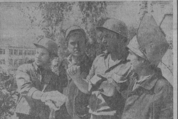
Растет Зеленогорск — поселок строителей Крайнего гидроузла на Томи. Здесь уже имеются школа, детские сады и ясли, магазины, несколько многоэтажных жилых домов. Продолжается строительство жилого массива. Успешно трудится бригада монтажников первого участка Анатолия Ивановича Тафинева.
