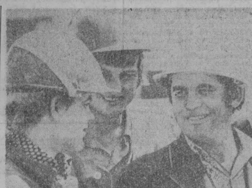
Бригада монтажников М. С. Полуларшинова хорошо известна в Прокопьевске. Это один из лучших строительных коллективов города. Монтажники возводили все крупнопанельные дома на Тыргане. Сегодня они начали строительство новой серии домов для работников фарфорового завода в третьем микрорайоне.
