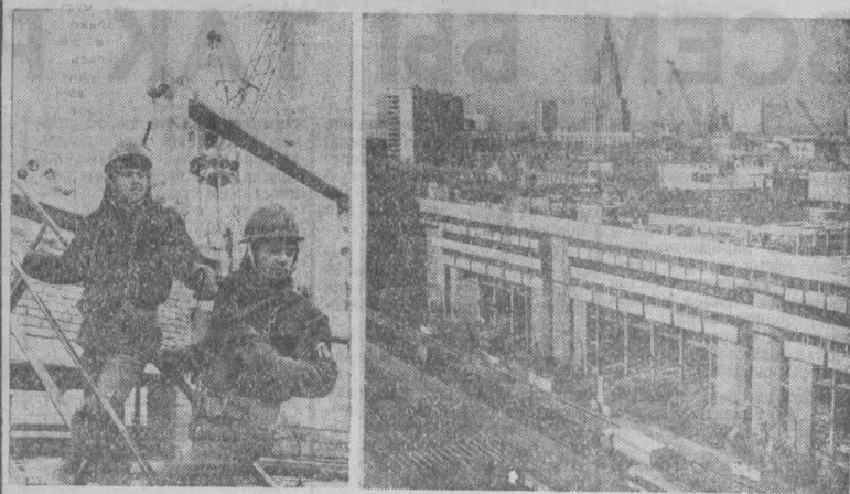
В МОСКВЕ большой размах приобрело строительство Олимпийских объектов. На Всесоюзной ударной комсомольской стройке, расположенной на Зубовском бульваре, все выше и выше поднимаются этажи главного пресс-центра. Его возводит монтажный управленческий строительный объединенный «Камгэсэнергострой».
