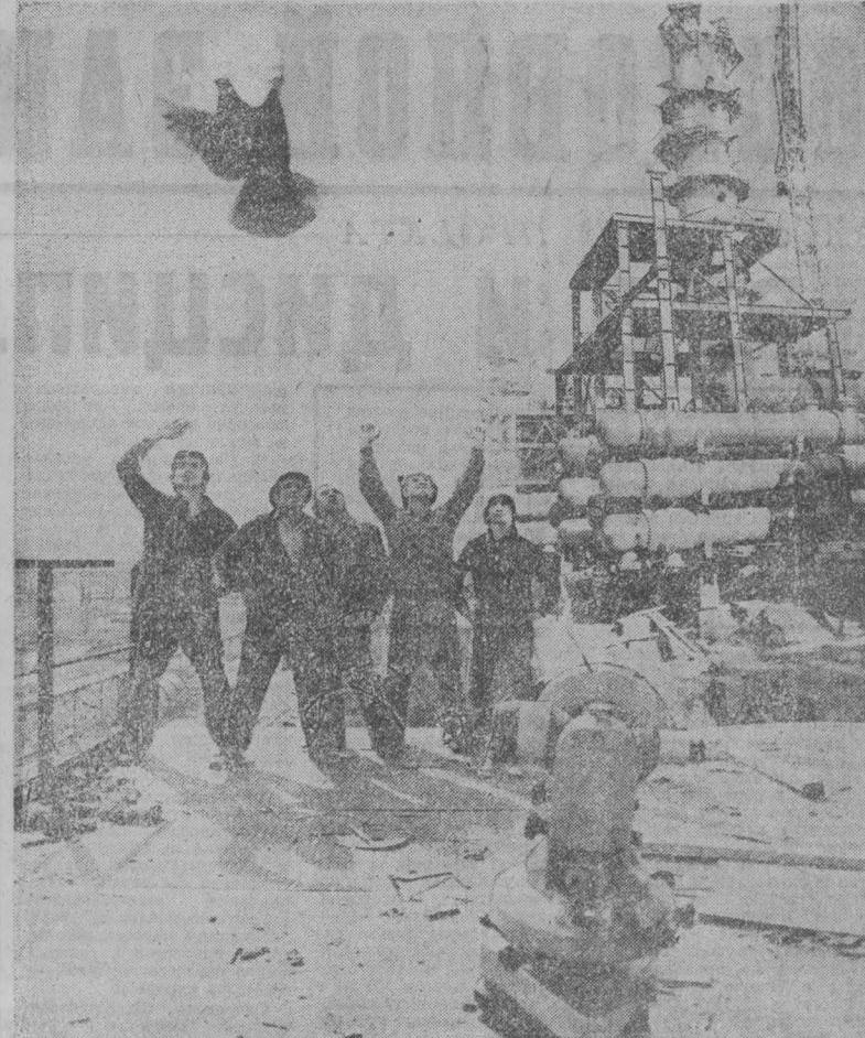
Монтажники Сергей Наумин, Василий Афанасьев, Андрей Черный, Геннадий Суздальцев и бригадир Николай Лопесов из Новокузнецкого монтажного управления № 1 треста «Сибметаллургомонтаж» успешно трудятся на строительстве комплекса аммиака-2. За короткий срок их руками был собран регенератор, сейчас им остается часть поднять абсорбер. г. Кемерово. Фото В. Гризыкина.
