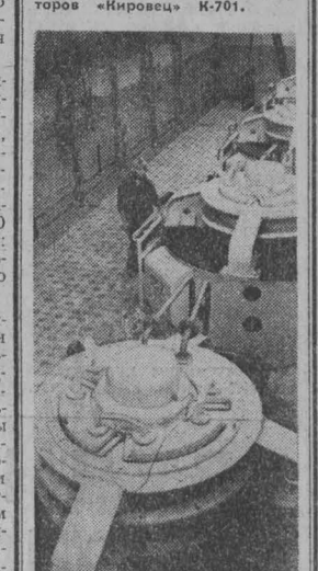
УКРАИНСКАЯ ССР. Успешно идет строительство Чернобыльской атомной электростанции. На реакторе заканчивается монтаж блочного щита управления.
