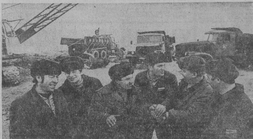
Как уже сообщал «Кузбасс», на сооружении уникального стада «З600» на заводе «Знак Почета» И. А. Трифонов из треста «Востокгидрострой». Механизаторы используют прогрессивную организацию труда — бригадный подряд. Коллективу приданы два экскаватора и два бульдозера, десять самосвалов. Воодушевленные постановлением ЦК КПСС, Совета Министров СССР, ВЦСПС и ЦК ВЛКСМ «О Всесоюзном социалистическом соревновании за повышение эффективности производства и качества работы, успешное выполнение заданий десятой пятилетки», механизаторы наращивают темпы, стремясь к весне преодолеть строительный фронт работ.
