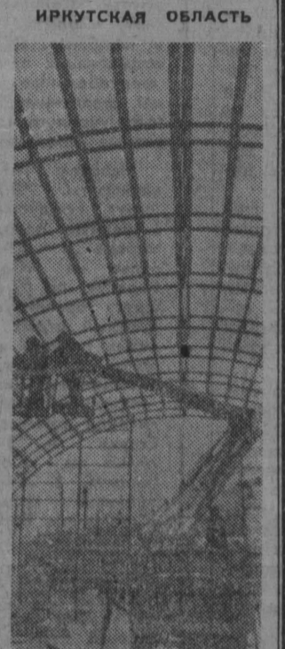
Полным ходом идет строительство западного участка Байкало-Амурской магистрали. На станции Лена сооружаются промышленные здания, гаражи, автомастерские.
