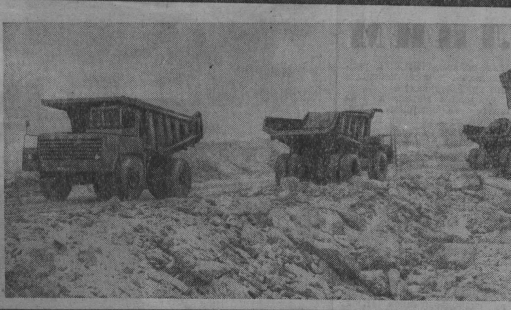
НА СНИМКАХ: идут вскрышные работы на участке № 6; машинист экскаватора Э. ШУЛЬЦ, бригадир В. М. СВЕТОВИЧ и помощник машиниста экскаватора Г. СПАРЫЖИН.
