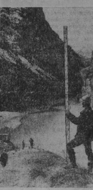
НА СНИМКЕ: ущелье Сулака, где будет сооружена Миятлинская ГЭС.
