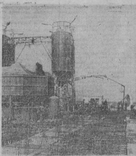
ПОЛЬША. Гданьский Северный порт продолжает расширяться. Строится нефтяной пирс, где будет перерабатываться ежегодно 6 миллионов тонн жидкого топлива.
