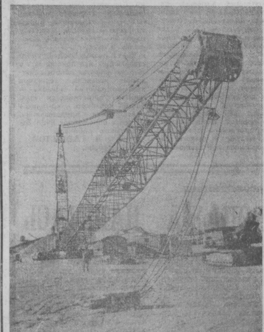
Уникальный гусеничный грузоподъемный кран построен в США для работ по сооружению будущего нефтяного порта Франци Антифер, близ Гаэра. Несмотря на впечатляющие размеры, кран весит менее 330 тонн. Длина стрелы — 60 метров. Он способен поднять 200 тонн на 11-метровую, 50 тонн на 40-метровую и 18 тонн на 60-метровую высоту. Снабжен 12-цилиндровым мотором мощностью 618 лошадиных сил.
