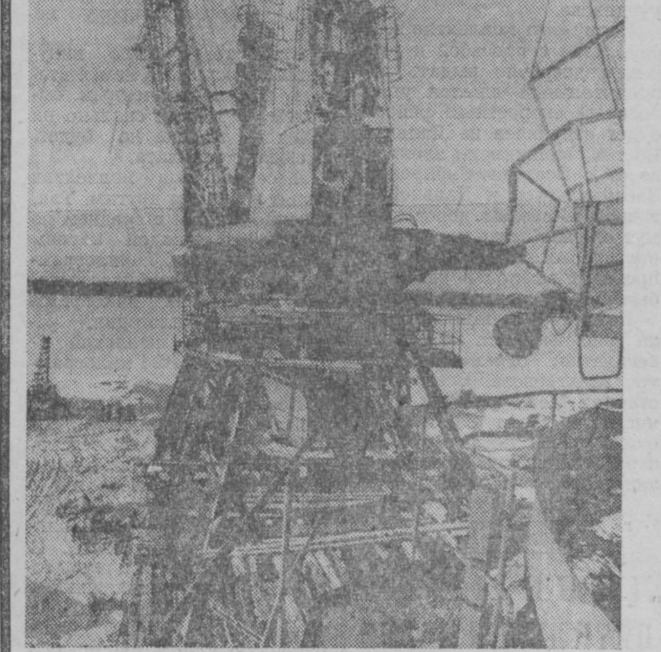
ТОМСКАЯ ОБЛАСТЬ. На Оби, у города Колпашево, колледж строительно-монтажного поезда № 299 треста «Томсктрансстрой» соорудят крупнейший в Западной Сибири речной порт. Его грузооборот составит 600 тысяч тонн в год. В комплексе порта-гавани входят причальная металлическая стена длиной 300 метров, 8 портальных и 2 крановых крана, закрытый склад на 4 тысячи тонн грузов, подъездные пути, административные здания, ремонтно-механические мастерские и другие вспомогательные службы.
