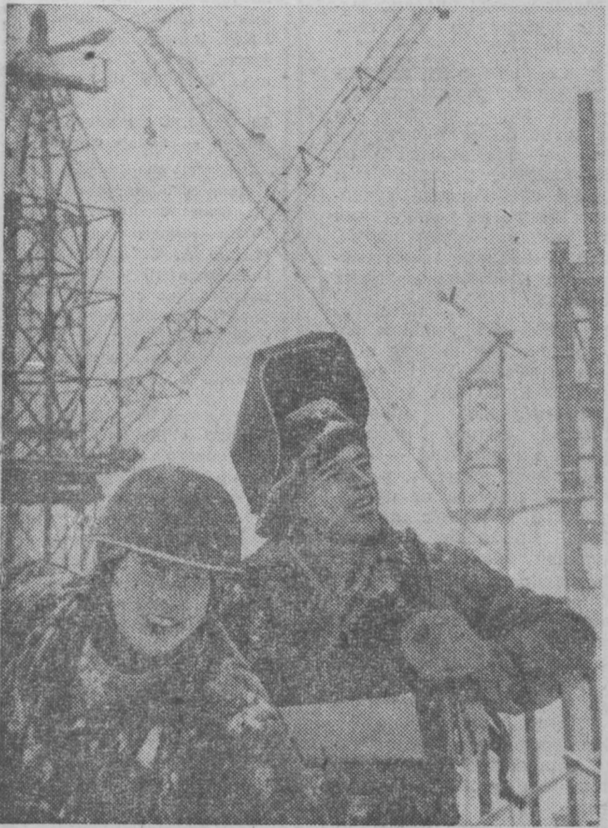
Так уж повелось — Запсиб строит вся страна. И на втором кислородно-конвертерном цехе завода — крупнейшем в стране сталеплавильном производстве — эта добрая традиция не нарушается. Варить «груши» конвертеров помогли сибирякам специалисты из Юданава. А на этом снимке читатель видит электросварщицу из Новокузнецкого управления № 1 треста «Сибстальконструкция» Владимира Щербачева и сталомонтажника из Красноярска Вячеслава Суслова. Они уверены: первая плавка в новом цехе состоится 20 марта, на десять дней раньше срока. Фото В. Грызыхина. г. Новокузнецк.
