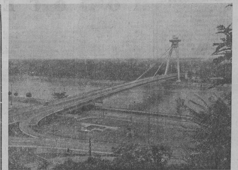
ЧЕХОСЛОВАКИЯ. Мост через Дунай в Братиславе, соединяющий центральную и западную части города. Своеобразная конструкция 430-метрового моста, подвешенного на одном громадном пилоне, не имеет себе равных в Европе. Ширина его — 20 метров. Уникальным сооружению присвоено имя Словацкого национального восстания. Фотохроника ТАСС.
