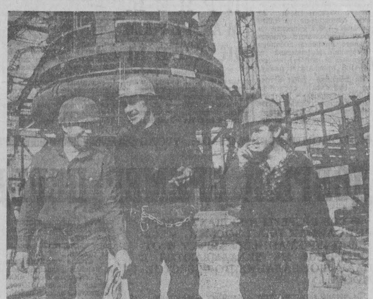
Строители доменной печи № 4 на Карагандинском металлургическом комбинате в Казахстане, рабочие-монтажники Владимир Костин, Анатолий Дитячев, Иван Меренов.
