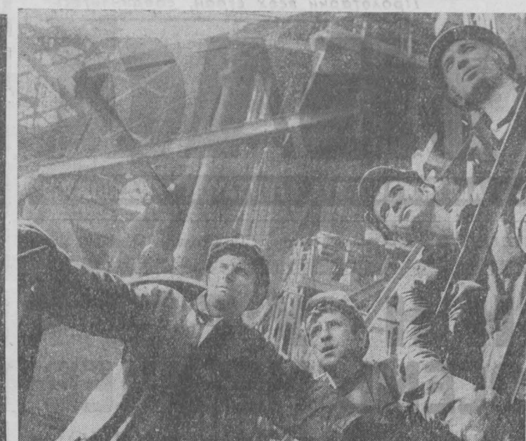
На Кузнецком металлургическом комбинате поставлена на капитальный ремонт вторая домная печь. Коллектив ремонтников управления «Уралдомремонт» дал слово быстро и качественно выполнить ответственное задание. В числе лучших на ремонт называют бригаду Сергея Ивановича Земцова.
