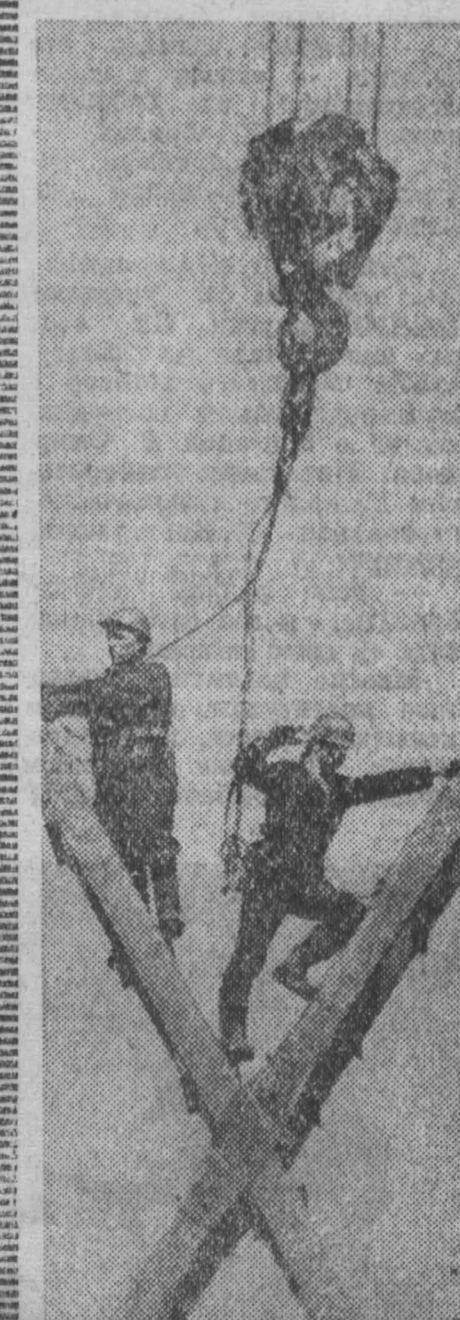
Полтора миллиона тонн угля в год — на триста тысяч больше, чем сейчас, — будет выдавать шахта «Проктовецкая» после реконструкции первой очереди. Коллектив шахтоуправления № 2 возводит новую котельную предприятия. На объекте по-прежнему трудится бригада Г. Шестака.
